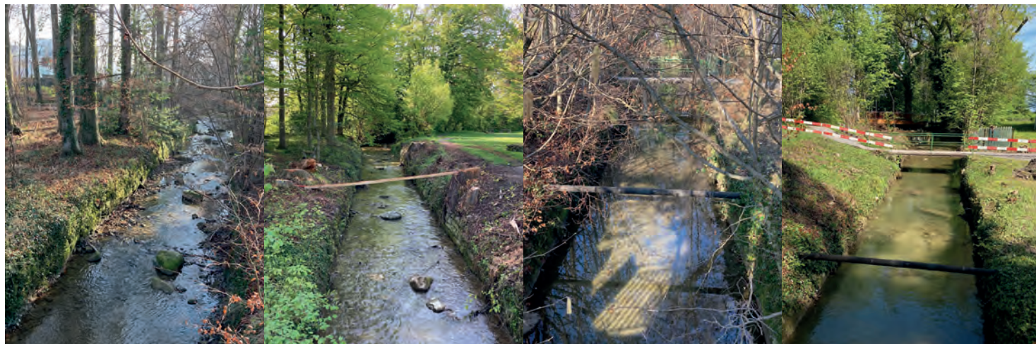
Bachaufwärts vor Rodung
